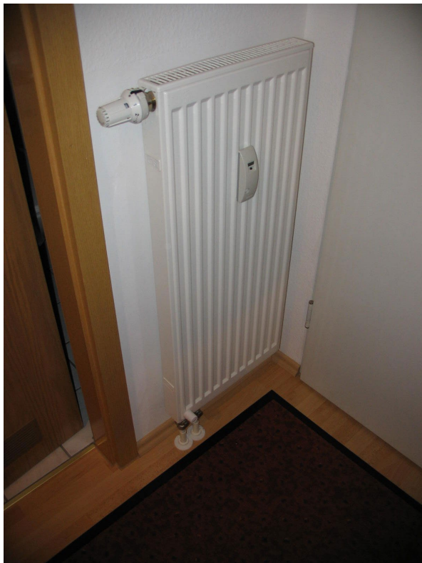
Normanschluss mit VL oben
