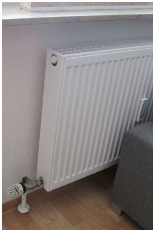
Reitender Anschluss mit VL unten
